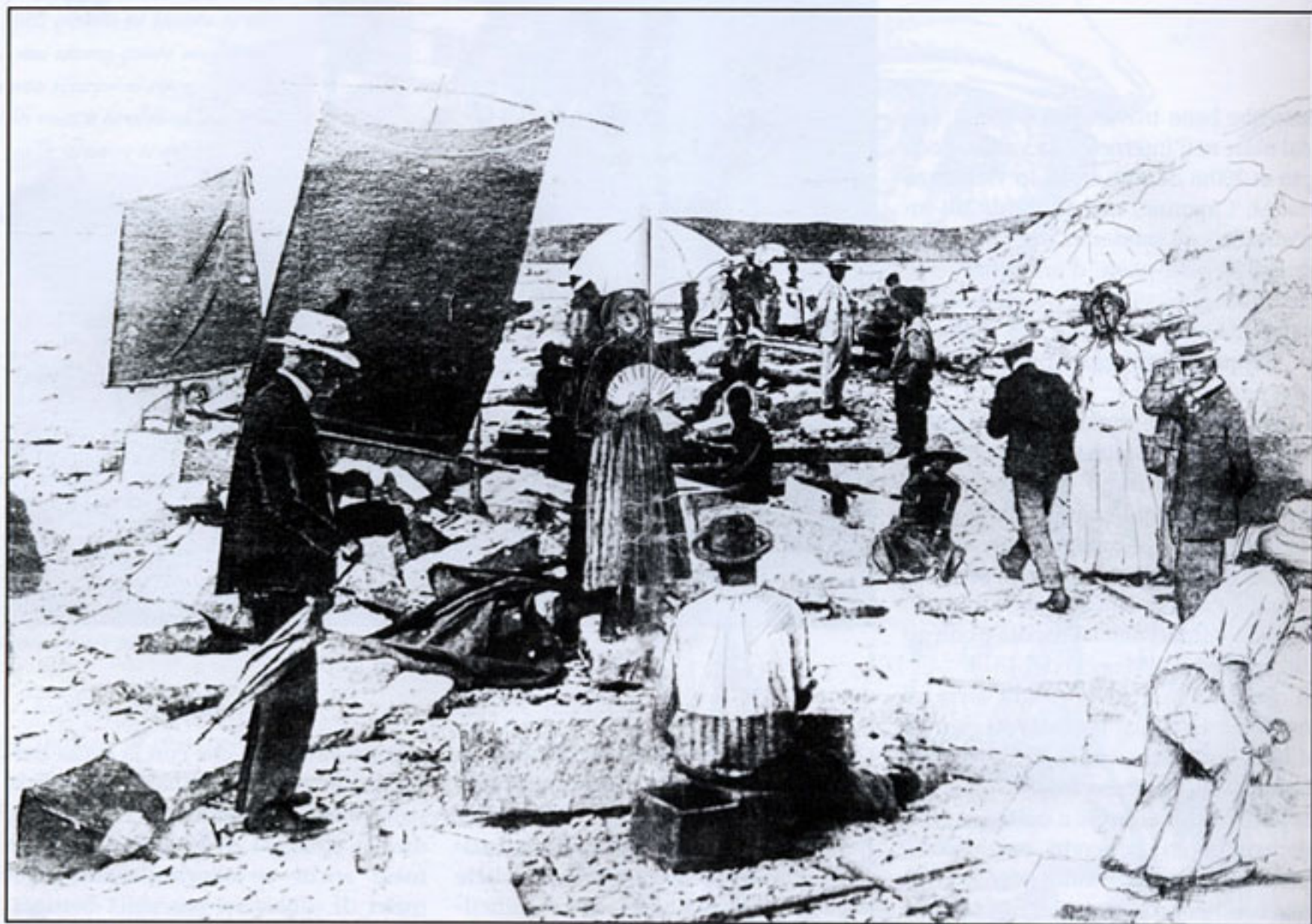
Lavorazione del granito anni venti al tempo dei Mellini ed il fattore Sig. Franchi. Si notano i binari per i vagoncini da trasporto.
